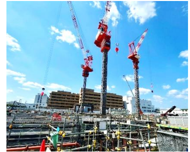
同じ病院敷地内で 新病院建設が進む
