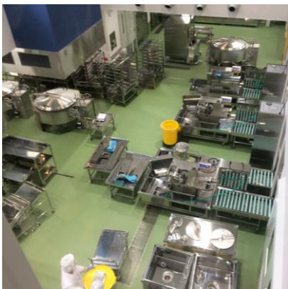
中学校給食センターの設備
